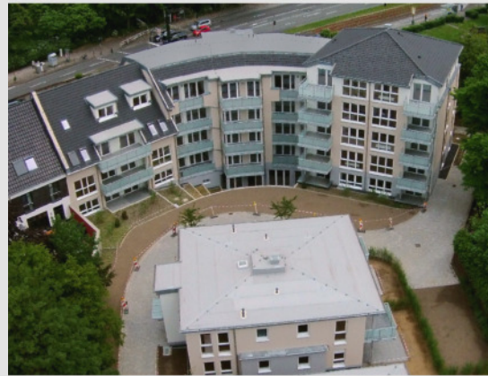
INNENHOF HAUS A
