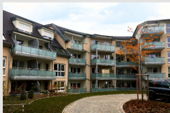
INNENHOF HAUS A
